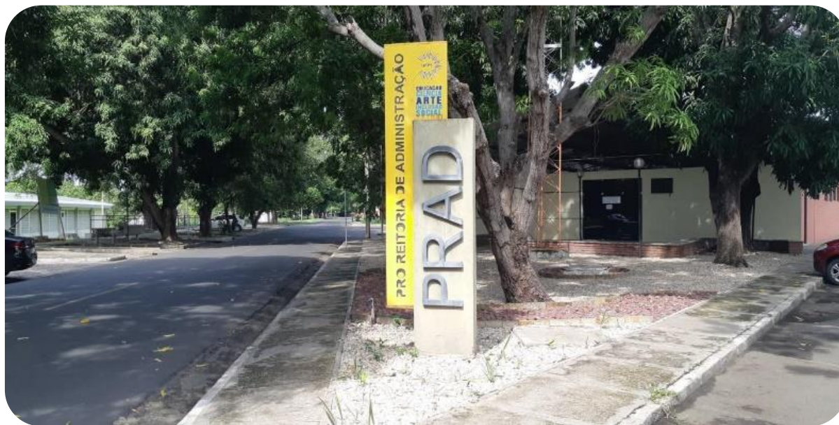
Figura 2- Fachada da PRAD
