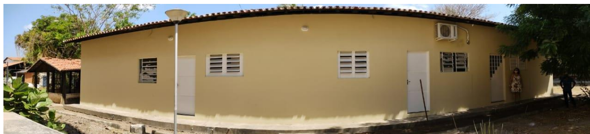
Figura 4 - Registro da fachada em reforma do Biotério Geral no bairro Socopo
