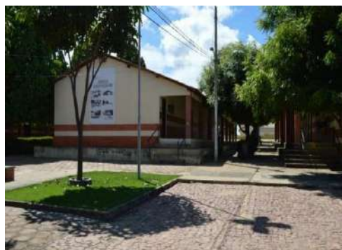
Figura 18 – Prédio do CTBJ Fonte: UFPI
