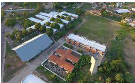
Figura 17 – Vista de cima do CTF Fonte: UFPI
