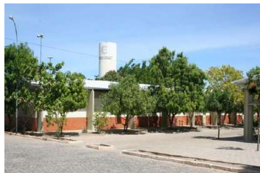
Figura 15 – Fachada externa do CSHNB, em Picos-PI Fonte: UFPI
